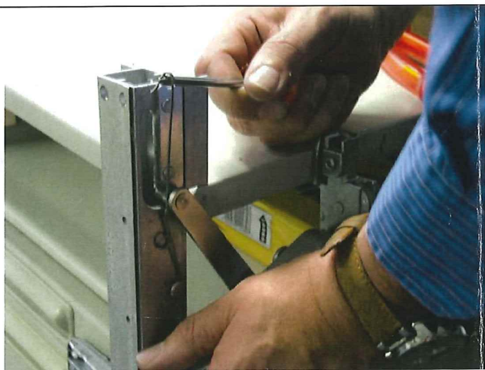
Schraubendreher in Schlaufe stecken - - - -
